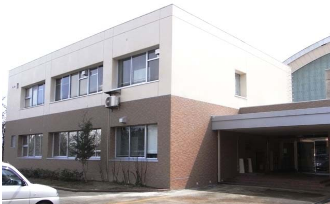
平成22年4月9日 改修なった体育・保健センター正面付近
